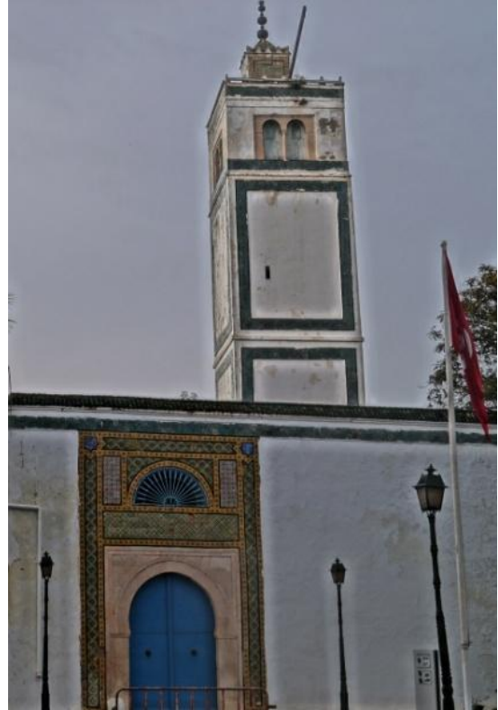
الصورة عدد 2 : الواجهة الرئيسية لجامع باردو
