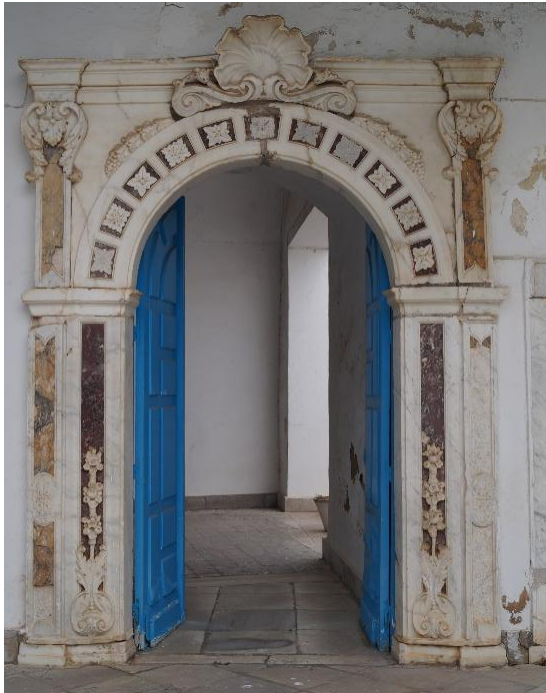
صورة عدد 12 : واجهة الصحن الداخلي
