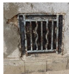
Fig 23. Aération du vide sous al-dokkāna à Dār Boukaddida (K. Sghira)
