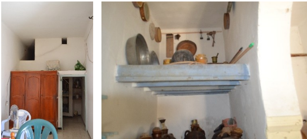
Fig. 1. Sidda maçonnée et en bois pour rangement (Borjine et el-Knaies).
