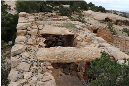
صورة 26. تقنية التسقيف بالألواح الحجرية.
