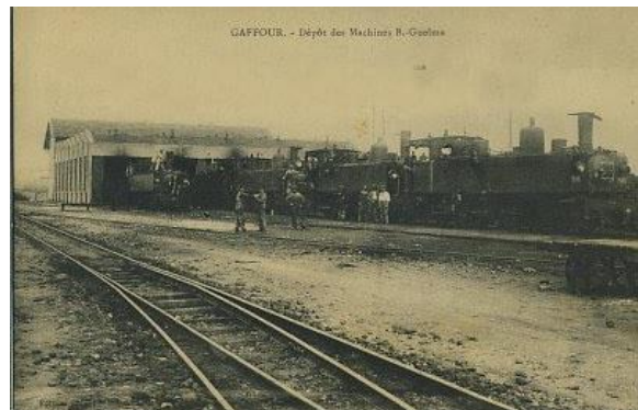
Fig.8. Dépôt de machines
