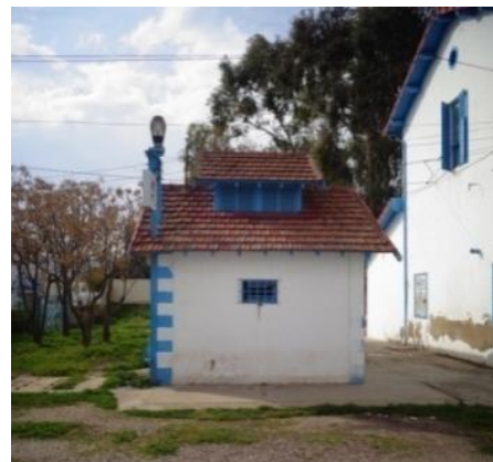
Fig.10. Le bloc sanitaire
