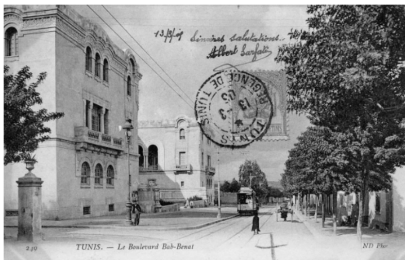
Fig. 1. Tunis, Boulevard Bâb Benat , le Palais de Justice, Arch. J. E. Resplandy, 1905 : l'édifice est aujourd'hui classé au patrimoine national. Source : collection privée.
