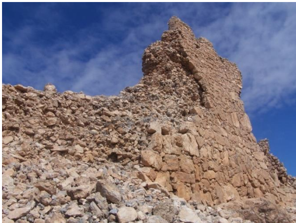
Fig. 33. Façade Sud, l'épaisseur du mur dépasse 1,50m. Cliché : Nouri BOUKHCHIM.
