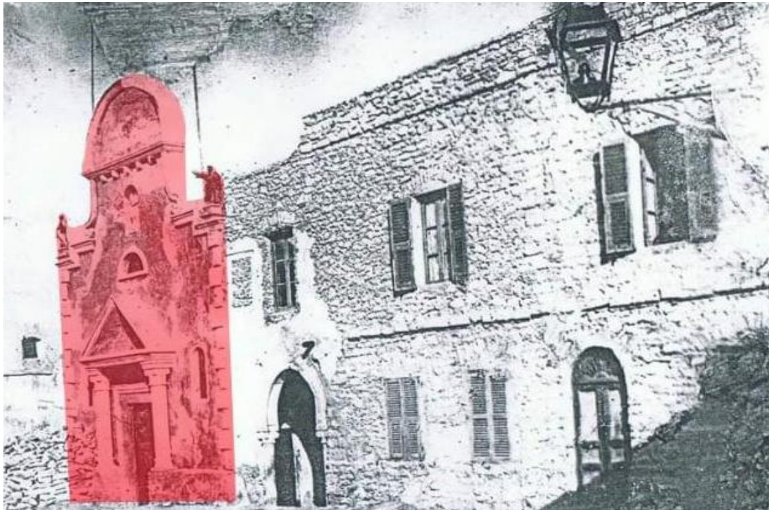
Fig. 3. La façade de l'église avant 1901.
