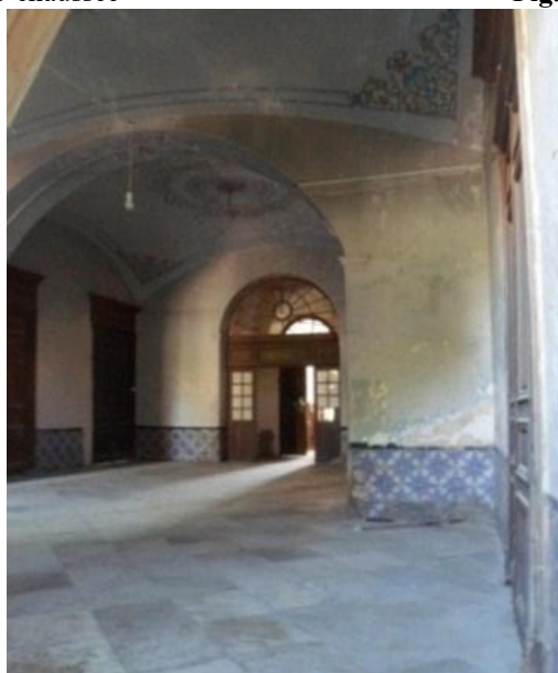
Fig.4. La céramique napolitaine de type CE81 est disposée en large frise formant une plinthe.
