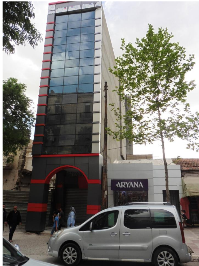
Fig. 8 : Remplacement de la Harat par un haut immeuble.
