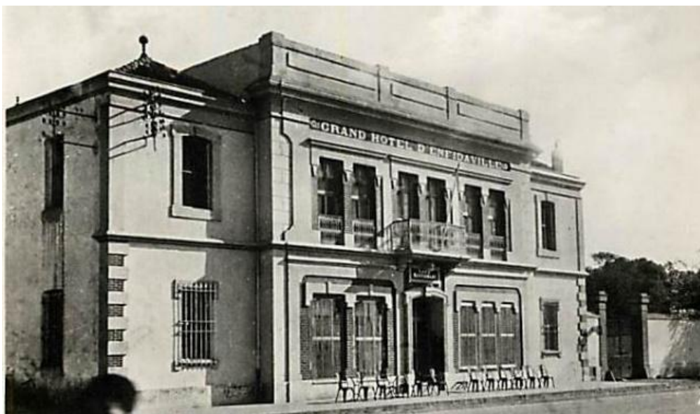
Fig.20. Ancienne façade du grand hôtel d' Enfidaville . Source : www.delcampe.net
