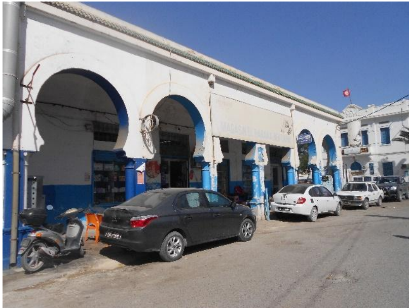
Fig.23. Vue en perspective – la galerie du fondouk Source : photo de l'auteur
