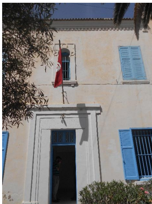
Fig.22. Porte principale du bâtiment des Ponts et Chaussées. Source : photo de l'auteur
