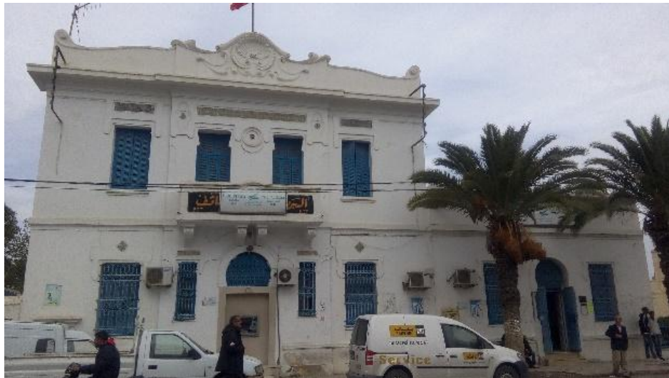
Fig.16. Façade Principale – La poste. Source : photo de l'auteur
