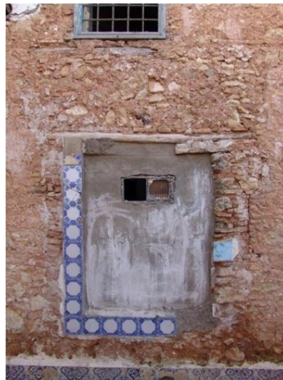
Fig. 10. Etat de stratification du mur donnant sur le patio de la Villa A - Djenân Mahieddine - (S. Chergui).
