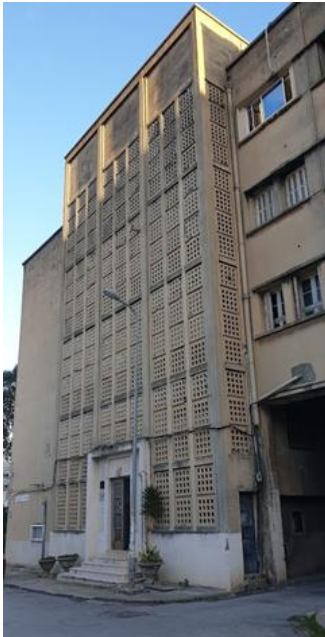
Fig.3. Dispositif claustra de la façade Nord-Ouest. Source : Photo de l'auteur.
