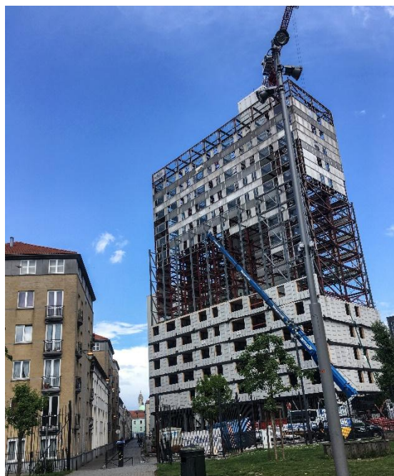
Fig. 7. La tour en chantier : démontage des murs rideaux et mise en œuvre progressive des nouvelles façades en ossature bois.
