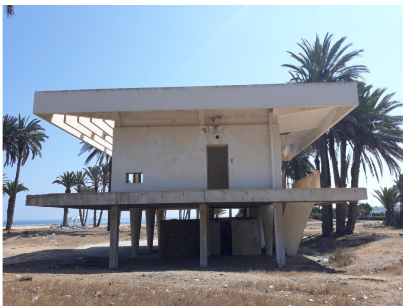
Fig. 5. Photographie d'un des cinq bungalows, 2018. Source : Photographie personnelle.
