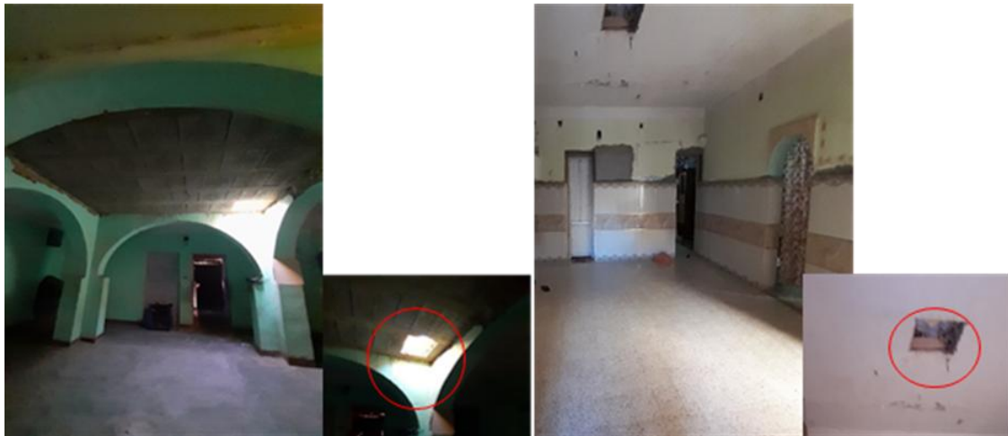
Fig.12. Le patio dallé en béton avec une petite ouverture. Source : Auteurs, 2022.
