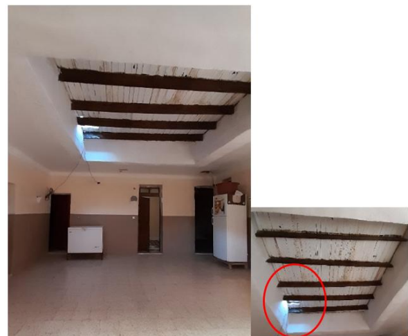
Fig.14. Patio couvert par des panneaux en bois avec démolition des piliers et des arcs. Source auteurs, 2021.
