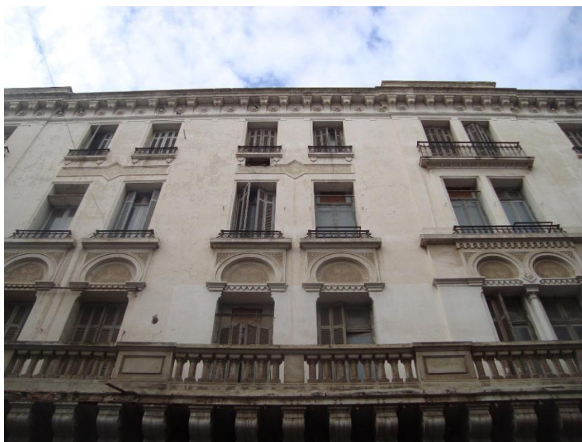
Fig. 8. Bat n°5, rue Charles de Gaulle. Arch. : Henri Piquart, 1908-1912. Source : Photo de l'auteur.
