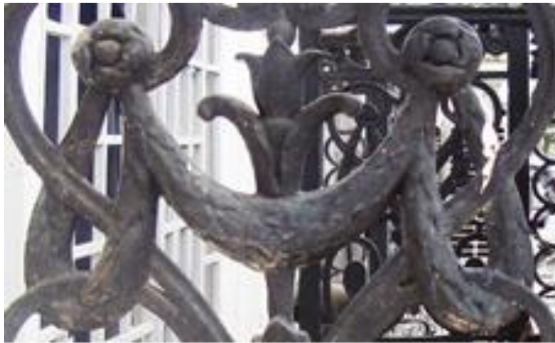
Fig. 3. Bat.n°22, rue Charles de Gaulle. Détail du balcon au 1 er étage.
