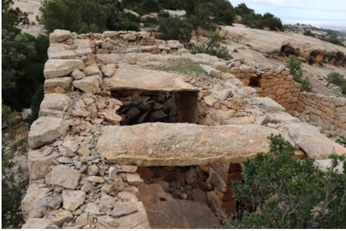
صورة 26. تقنية التسقيف بالألواح الحجرية
