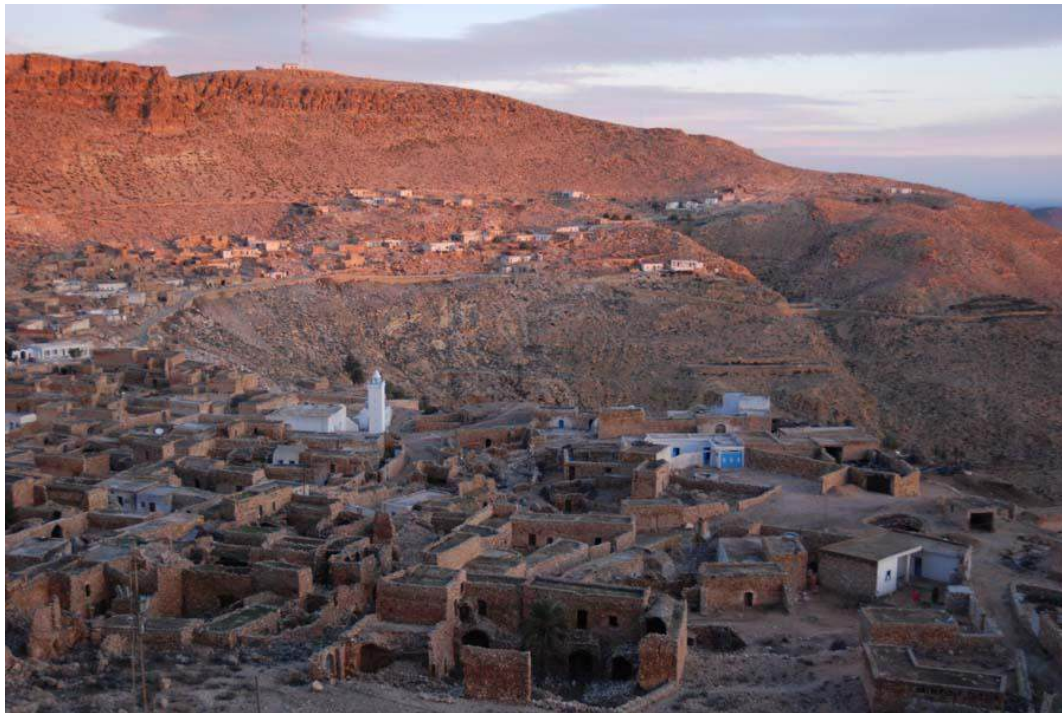
Fig. 10. Vue générale de Toujane. Cliché : Asma SEKMANI.
