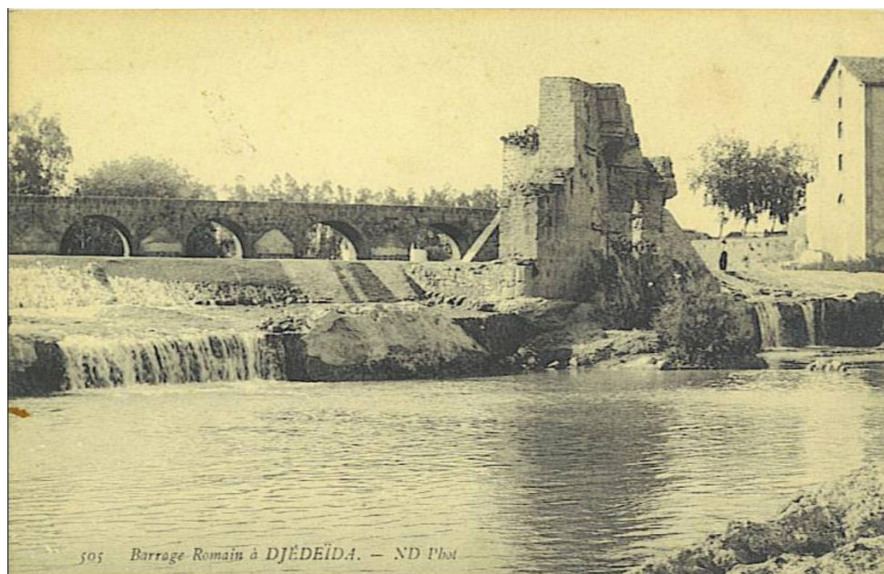
Fig. 4. Le pont de Djedeida construit en 1616 par Youssef Dey. Les arches égales sont établies sur un radier assez haut, construit sur toute la longueur de la rivière de sorte que l'eau en la traversant se déverse en cascade. Carte postale vers 1900. Collection Chawki Dachraoui.
