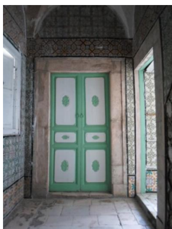
Fig. 13 : La porte de la sqifa (vue du vestibule). Photo de l'auteure le 15-02-2018.
