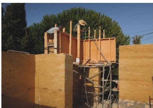
Fig. 4. Mise en œuvre de la terre
