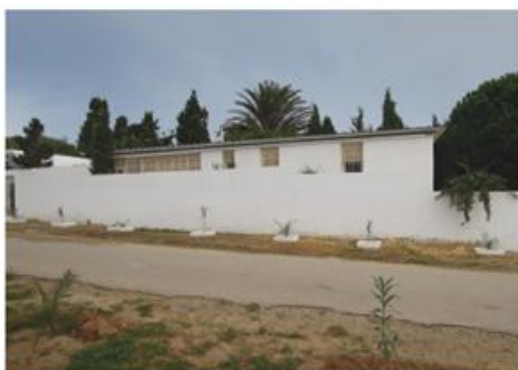
Fig. 6. État final de la construction
