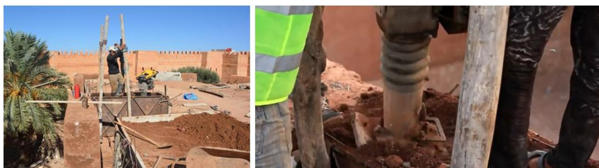
Fig. 2. Coffrage métallique du mur (à gauche),
