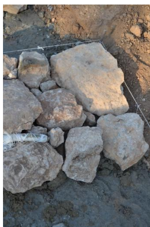
Fig. 12. Construction du soubassement en pierres
