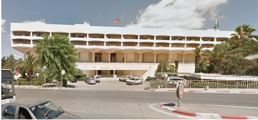
Fig.21. Maison du Parti du Néo-Destour, Mohamed Taïeb Haddad 1974. Source : Google maps
