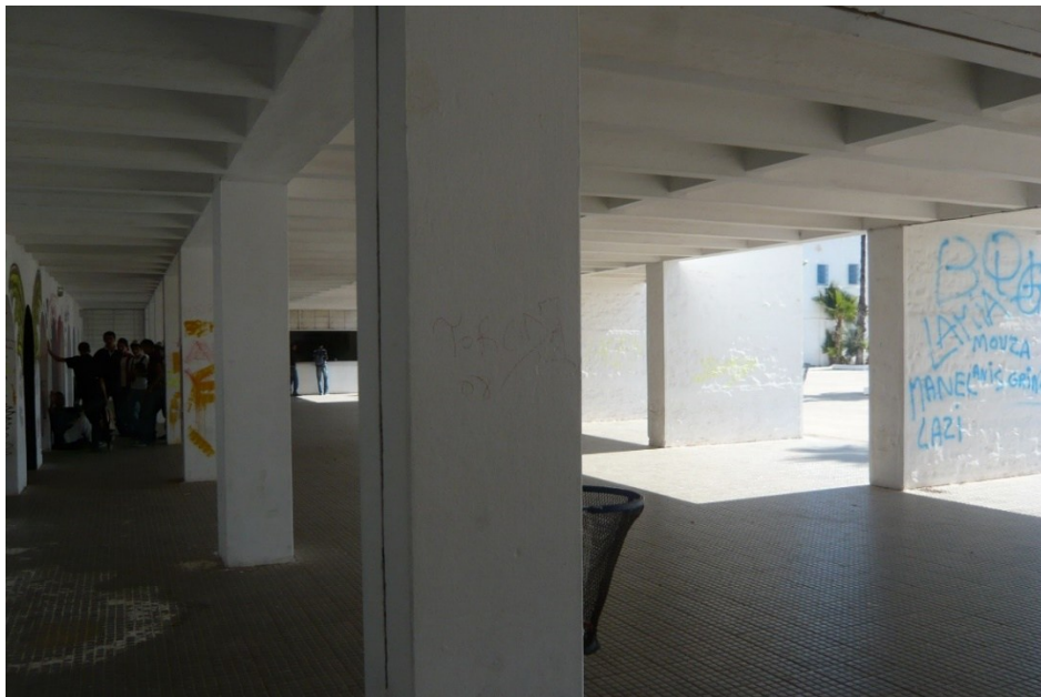
Fig.13. Le préau vu depuis l'intérieur.
