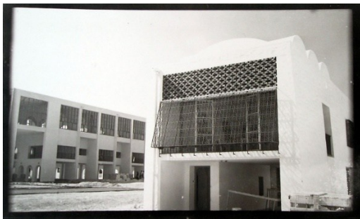
Fig. 5. Régulation lumineuse habitation du surveillant général. Source : Institut français d'architecture, Centre d'archives d'architecture du XX e siècle, Fonds Jacques Marmey (1906-1988) 21 Ifa
