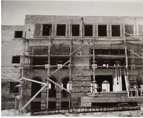
Fig. 7. Technique mixte moellons lits de briques. Source : Institut français d'architecture, Centre d'archives d'architecture du XX e siècle, Fonds Jacques Marmey (1906-1988) 21 Ifa
