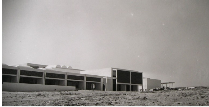
Fig. 3. Recours à la voute dans les dortoirs. Source : Institut français d'architecture, Centre d'archives d'architecture du XX e siècle, Fonds Jacques Marmey (1906-1988) 21 Ifa
