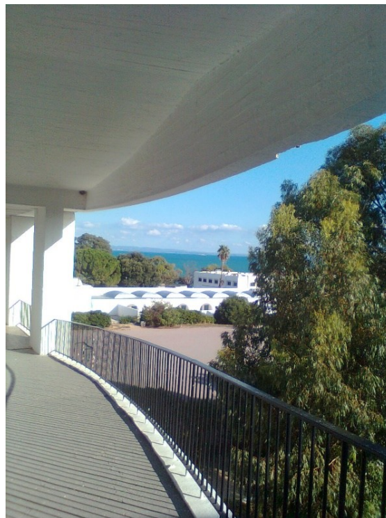
Fig.11. La rampe reliant le bâtiment des classes au bâtiment administratif. Source : auteure
