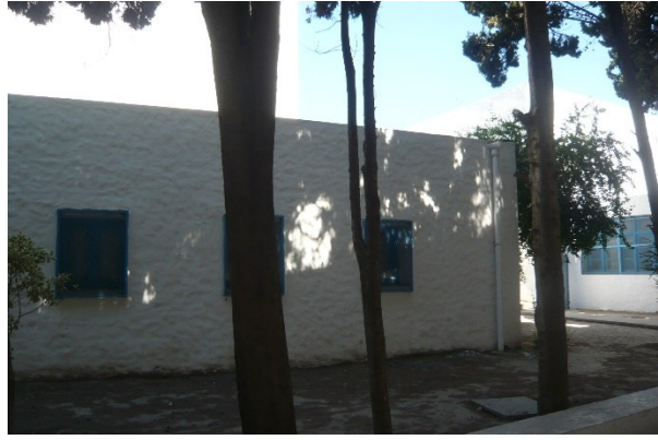
Fig. 8. Enduit bâtard taloché. Source : Auteure
