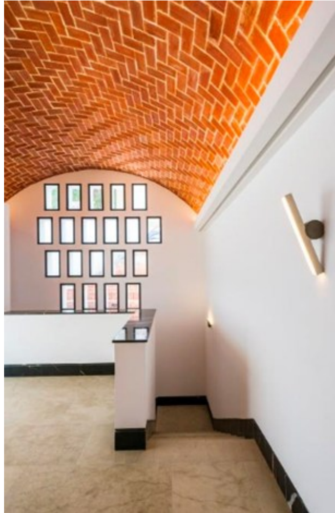
Fig. 15. Photo montrant l'espace architectural sous la voûte.
