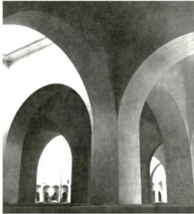
Fig. 5. Une vue sur la voûte d'arête dans le marché de Bizerte Zarzouna (1945-1946) réalisé par Bernard Zehrfuss, Jean Drieu La Rochelle et Jason Kyriacopoulos. Source : expositions-virtuelles.citedelarchitecture.fr/EXPO-ZEHRFUSS/01-PARTIE-DOC04.html
