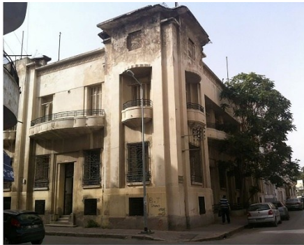
Villa Boublil, abandonnée, quartier du belvédère
