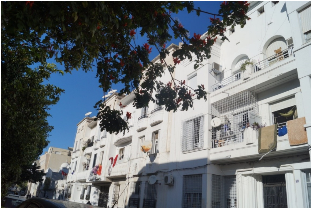
Fig. 9. 32-34 rue d'Arles. Source : photographie personnelle, 2018.
