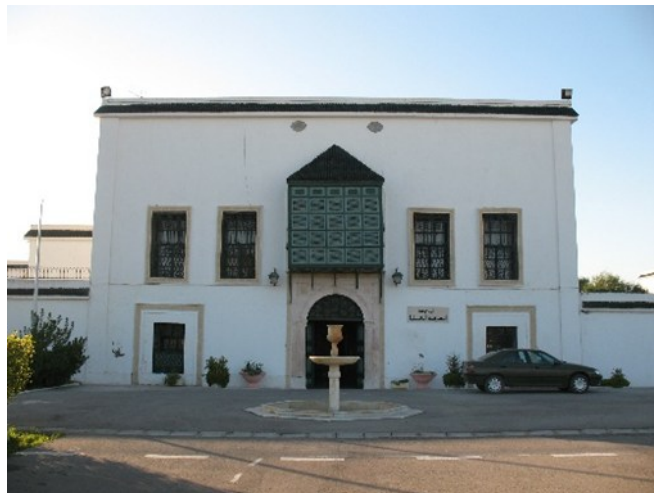
Fig.6. Façade de Bortal Haydar . Source : photo de l'auteure
