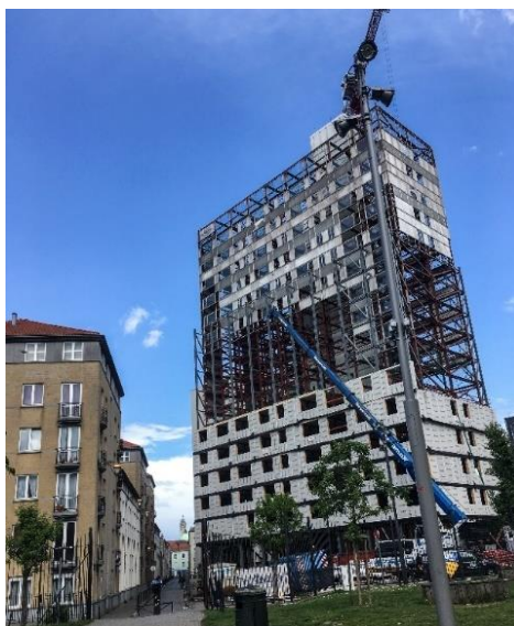
Fig. 7. La tour en chantier : démontage des murs rideaux et mise en œuvre progressive des nouvelles façades en ossature bois. Source : Lieven Soete, mai 2021.
