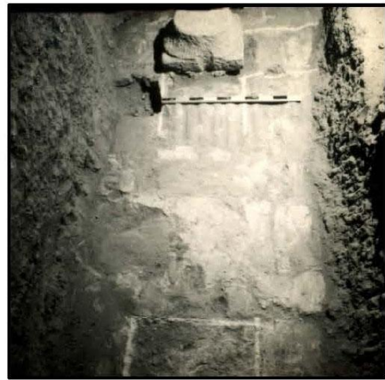
Fig. 2. Base d'une colonne posée sur un pavement en briques cuites appartenant à la mosquée du VIII e siècle. Source : Archives INP.
