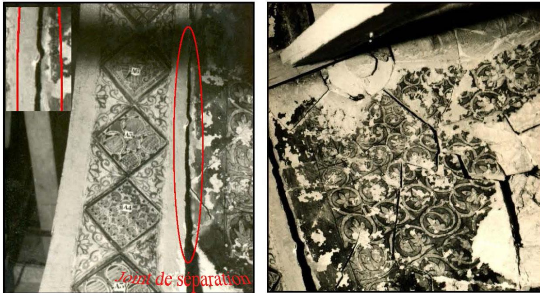
Fig. 5. Joint de séparation entre le cul-de-four à parement en pierre taillée à décor peint et l'arc de tête actuel.
