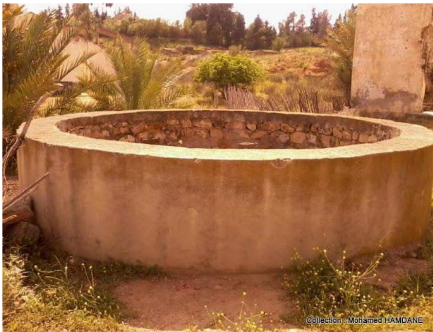
Fig.4. Puits dans la mine de Djebel Hallouf. Source : Mohamed Hamdane, 15 novembre 2017.
