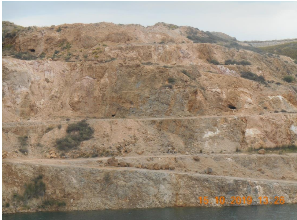
Fig.11. Vue du bord du lac artificiel montrant le niveau de terre creusée à Ghzala. Source : photo de l'auteur.
