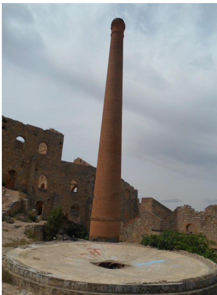
Fig.5. L'ancienne cheminée de la fonderie de Djebel Ressas. Source : photo de l'auteur.
