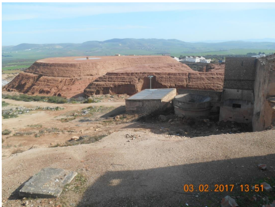
Fig.16. Remblais de déchets miniers à Djebel Hallouf- Bou Aouane (pl, zc.). Source : Photo de l'auteur.
