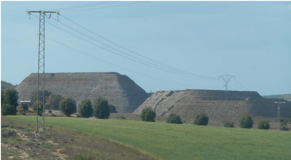
Fig.17. Remblais de déchets miniers à el Akhouat (pl-zc). Source : Photo de l'auteur.
