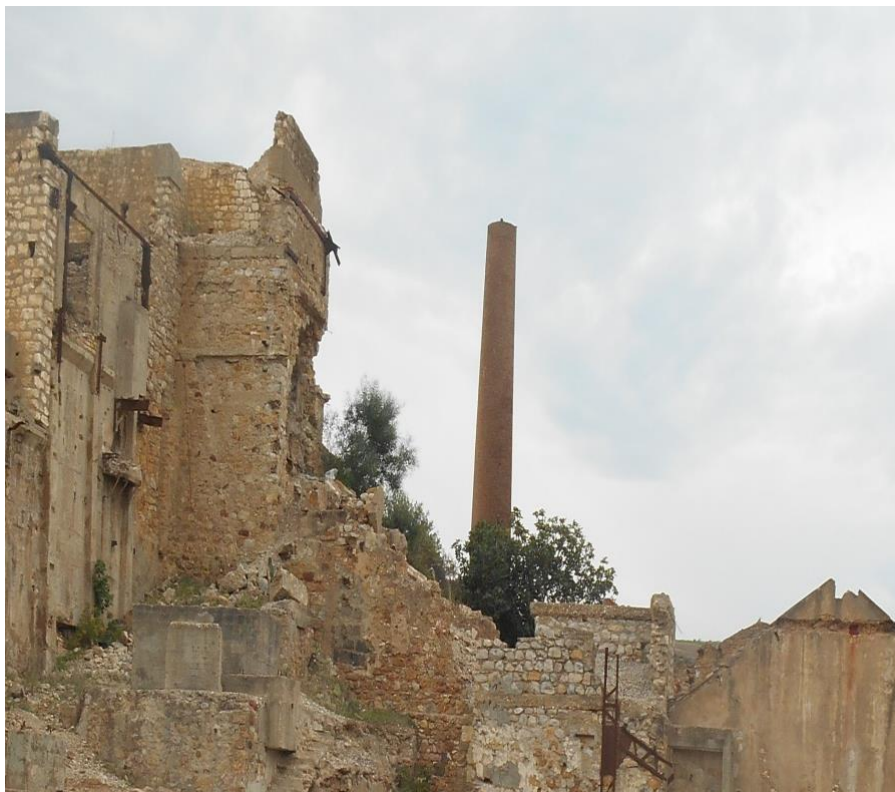
Fig.8. Cheminée de fourneau à Ghzala (Fe). Source : photo de l'auteur
