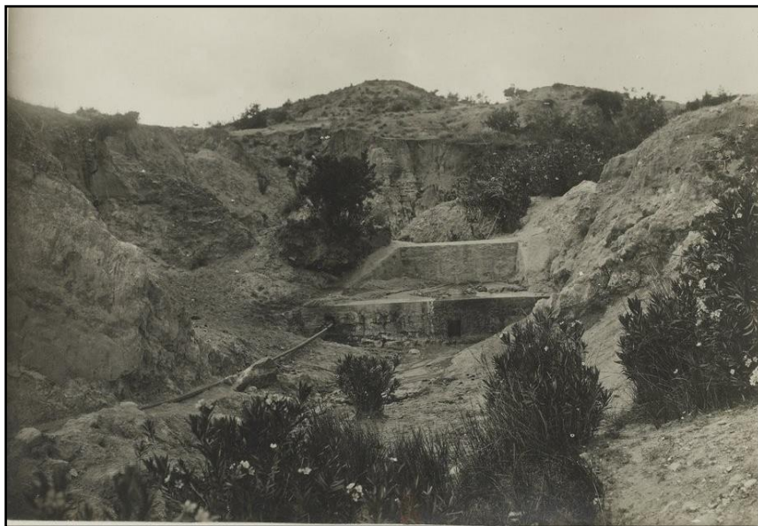
Fig.2. Captage des sources d'eau dans l'Oued ben Zitoun pour alimentation de laverie. Source : Syndicat de la mine du Djebel Trozza, 1918.
