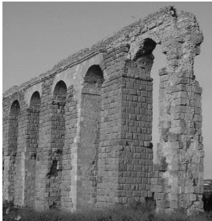
Fig..1. aqueduc aérienne. Source : M. Ben Ouezdou, 2012
