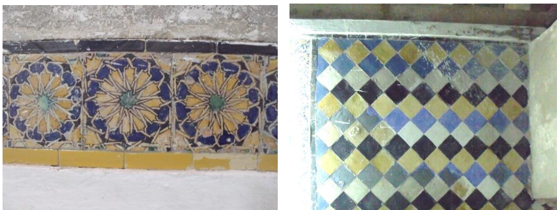
Fig. 36 et 37. Revêtement de faïence de Qallaline.
