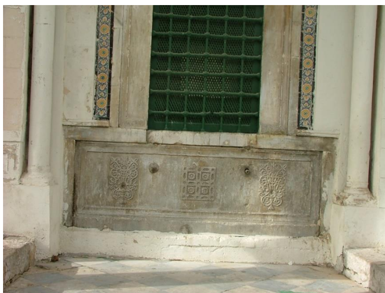
Fig. 27 et 28. Al-sabîl : c'est une fontaine murale placée sous la galerie extérieure orientale à gauche de la porte d'entrée de la mosquée, celle qui donne sur le souk al-Mushîr . Source : Photo de l'auteur, 25-2-2005.
