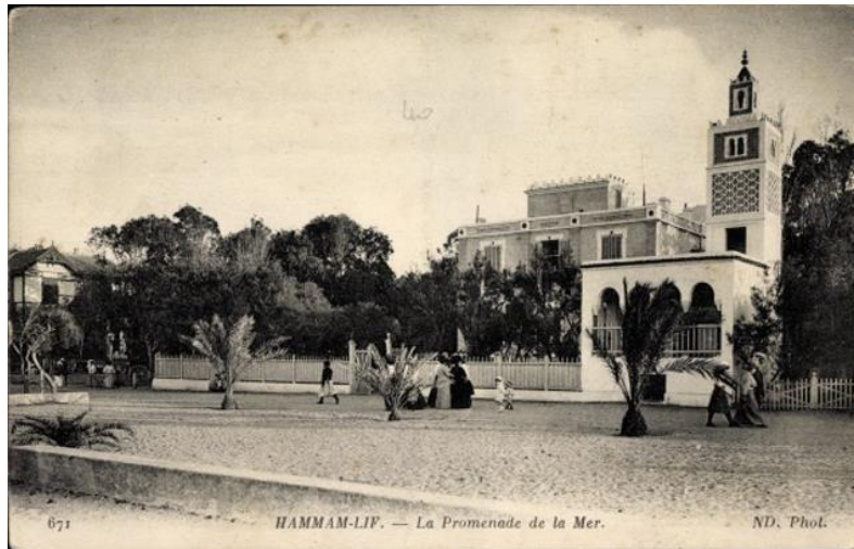
Fig. 7. Hammam-Lif , la Promenade de la Mer en 1910 ( actuelle corniche, Boulevard B'Chira Ben Mrad).
