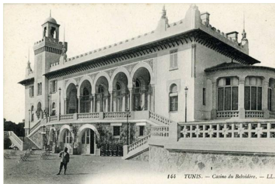
Fig. 7. Aspect extérieur du Casino du Belvédère.
