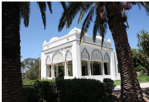
Fig. 5. Aspect général de la koubba du Belvédère. Source : photo de l'auteur.
