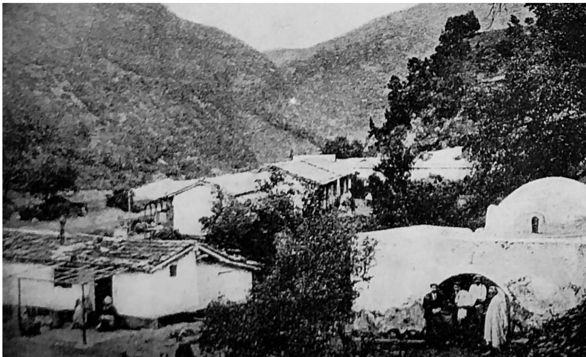
Fig. 3. Vue générale sur l'ancien village de hammam Mélouane et qubbat Sidi Slimane, avant les travaux de réhabilitation et de construction (Ofalac, ANI, série n°712, 1934).
