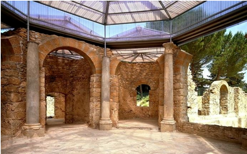
Fig. 6. Une toiture translucide pour protéger la mosaïque et connexion intérieur/ extérieur entre les espaces. Source : www.hitsicily.com/fr/piazza-armerina-mosaïque-villa-romana-del-casale-enna-sicile-location-maison-villa-luxe-vacances .
