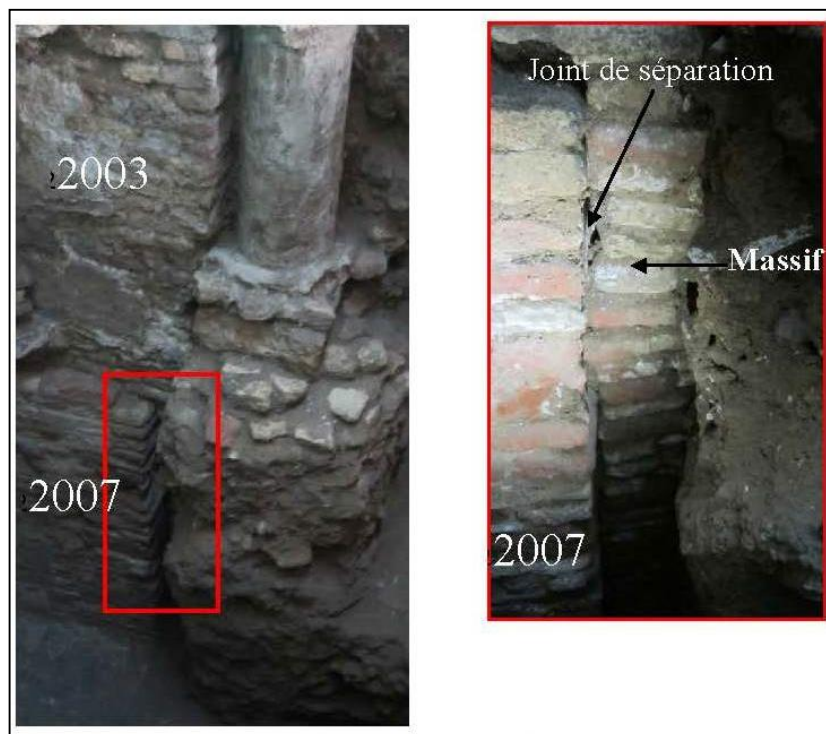
Fig. 11. Joint de séparation prouvant que les massifs sont postérieurs à la date de construction du mihrab 2007. Source : Photo de l'auteur.
