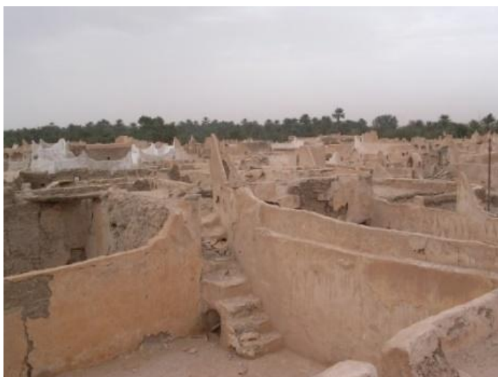
Fig. 20. Escaliers sur les terrasses créant un chemin.
