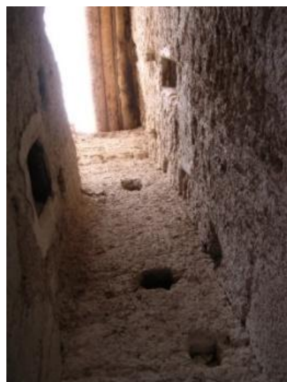
Fig. 21. Planches pour le passage.
