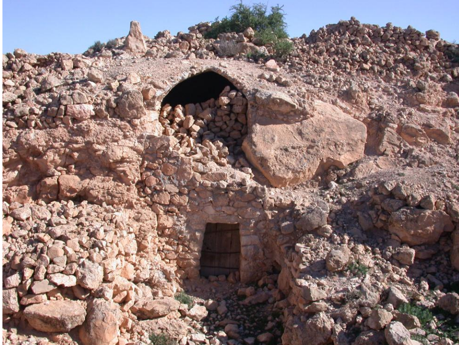
Fig. 12. Citadelles Sud et Sud-ouest (Cliché : N. BOUKHCHIM).
