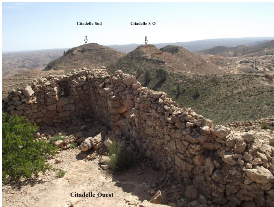
Fig. 14. Citadelles Sud et Sud-ouest (Cliché : N. BOUKHCHIM).
