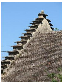
Fig 20. Pignons à redents d'une maison de Brégnier-Cordon, dans le Bugey
