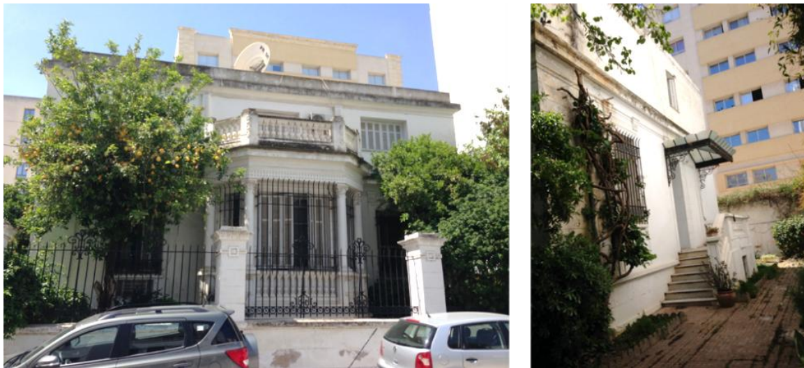
Fig. 5. Photos actuelles de la villa Staraci, Photos de l'auteur 2018 .
