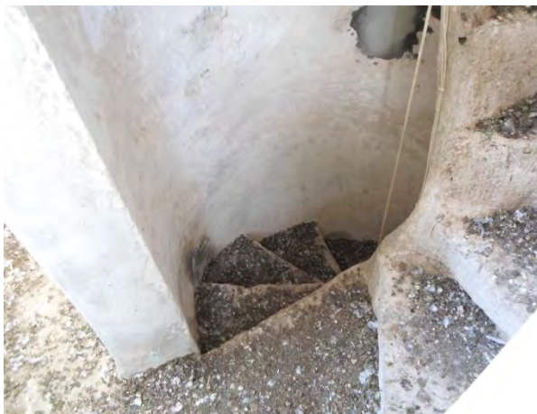
Fig. 10. La mosquée de Djedeïda. L'escalier en colimaçon de type andalou remonte à l'époque de la fondation de la mosquée. Photo Kais Ben Achour.
