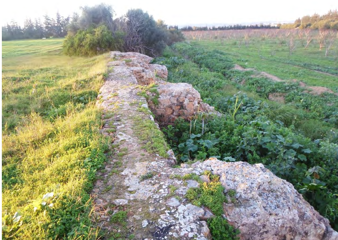
Fig. 19. Le pont-barrage d'El-Battan. En amont du barrage une digue du réservoir destinée à contenir l'eau. La digue est consolidée par des contreforts. Photo Slim Badri, 18-11-2018.
