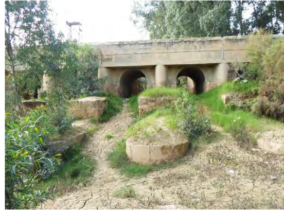
Fig. 16. Le pont-barrage d'El-Battan. Photo de Slim Badri, 18-11-2018.
