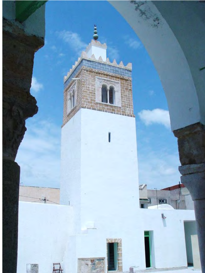
Fig. 36. Le minaret se dresse sur le côté Nord de la cour. C'est une tour carrée dotée de fenêtres géminées et portant un lanternon carré. Photo de l'auteur, 8-5-2004.
