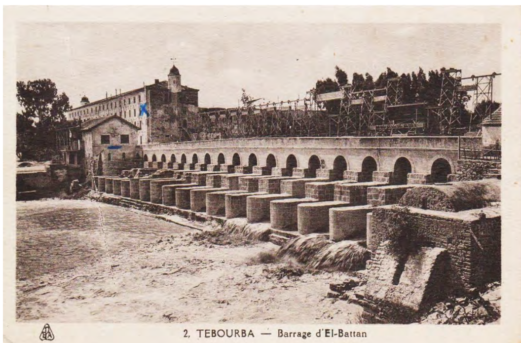
Fig. 12. Le pont-barrage d'El-Battan. On aperçoit la foulerie et la fabrique de draps d'Ahmad Bey.
