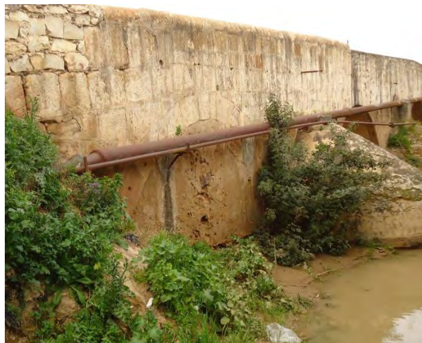
Fig. 5. Le pont de Djedeïda. La huitième arche bouchée depuis le XVII e ou le XVIII e siècle. Photo de l'auteur, 4-3-2012.
