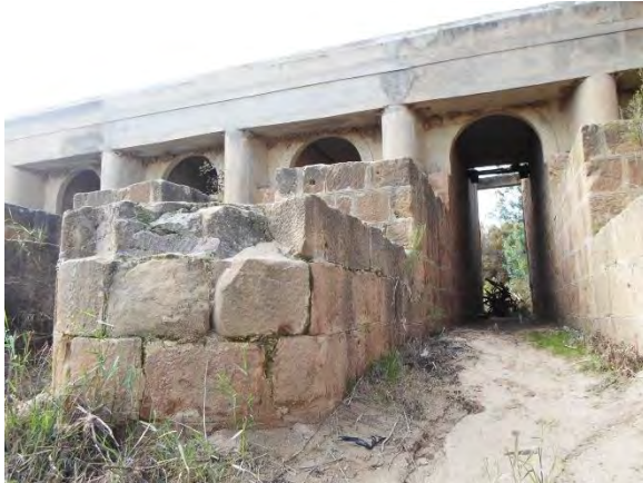
Fig. 15. Le pont-barrage d'El-Battan. Photo de Slim Badri, 18-11-2018.
