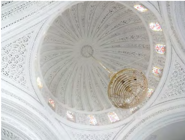
Fig. 52-53. La zawiya de Sîdî Ben 'Issâ. Les parties hautes des murs, les voûtes et les coupoles sont tapissées de stuc finement sculpté. Photo de l'auteur, 16-10-2016.
