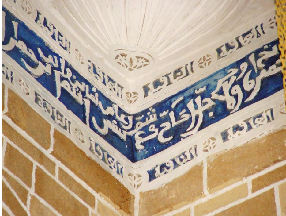
Fig. 35. A la base de la coupole une inscription historique qui date sa construction (1080/1670). Photo de l'auteur, 8-5-2004.
