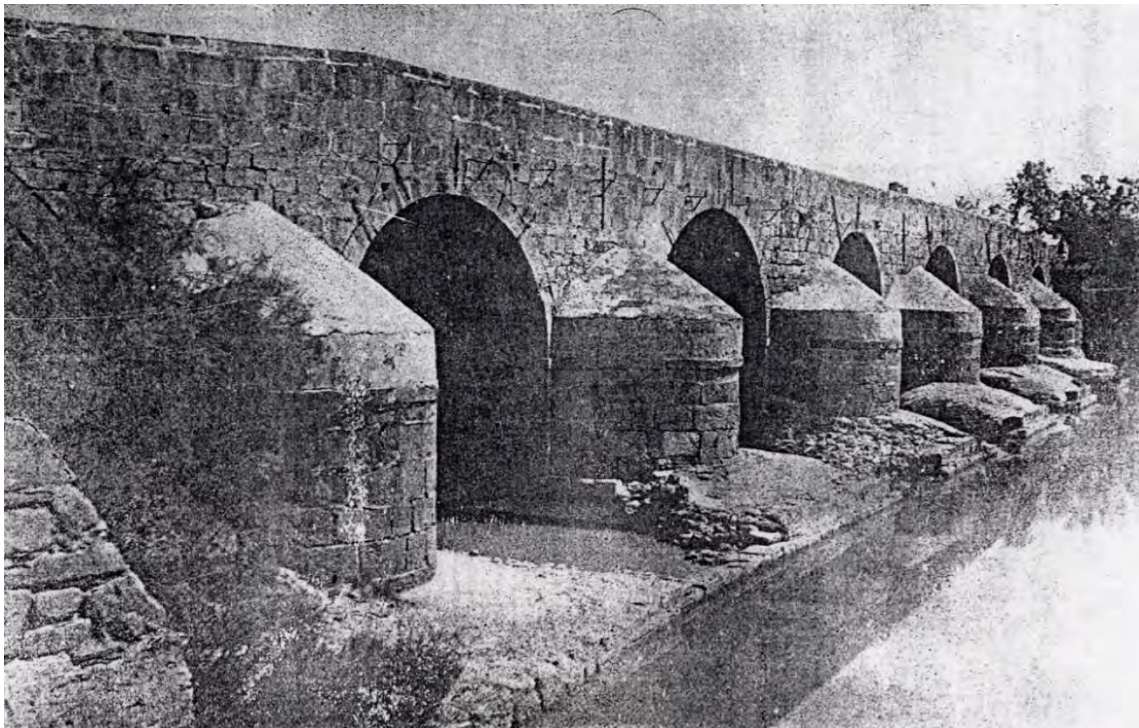
Fig. 2. Le pont de Djedeïda qui fut terminé en 1025/1016 a été édifié sur ordre de Youssef Dey.
