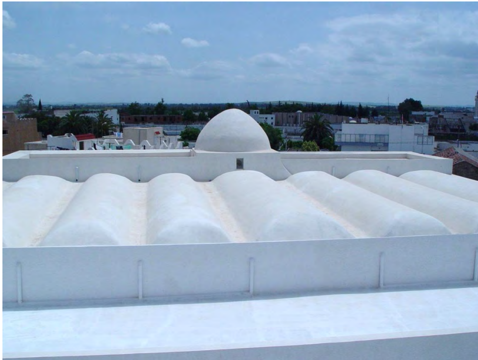
Fig. 30. La couverture actuelle de la salle de prière de la Grande mosquée. Photo de l'auteur, 08-05-2004.
