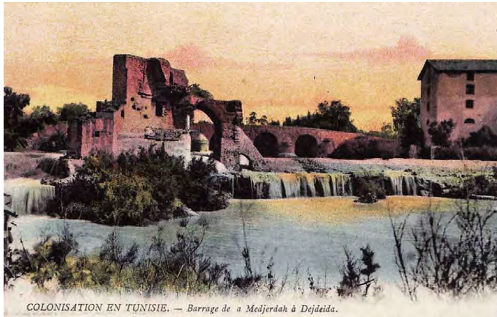
Fig. 7. Le pont de Djedeïda. Les arches égales sont établies sur un radier assez haut, construit sur toute la longueur de la rivière de sorte que l'eau en la traversant se déverse en cascade.
