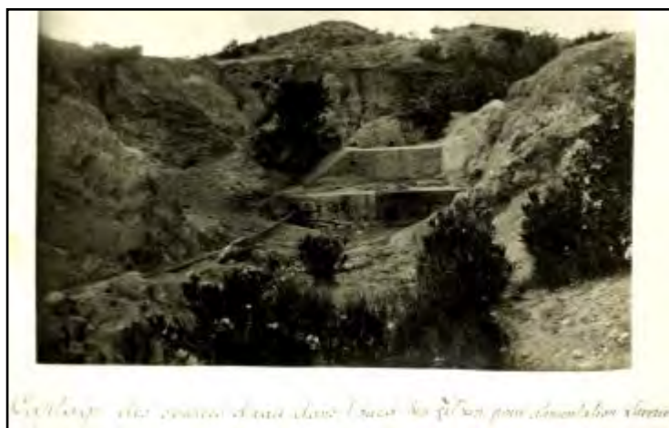
صورة 8. مستجمعات ينابيع وادي بن زيتون من أجل تزويد مغسلة جبل طرزة بالمياه.
