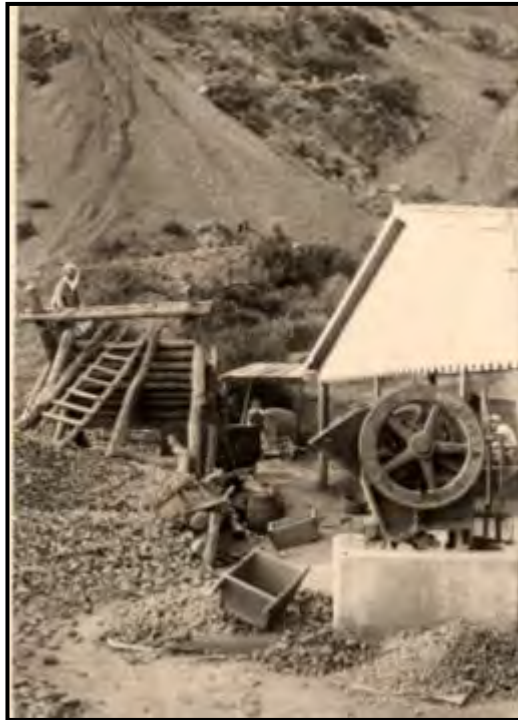
صورة 7. أسلاك فضائية وآلة مفتتة للحجارة. المصدر: Syndicat de la Mine de Djebel Trozza, 1918
