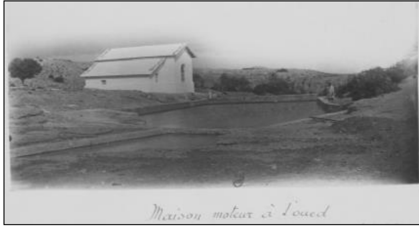
صورة 9. بيت المحرك الخاص بضخ المياه في وادي بن زيتون. المصدر: Syndicat de la Mine du Djebel Trozza, 1918.
