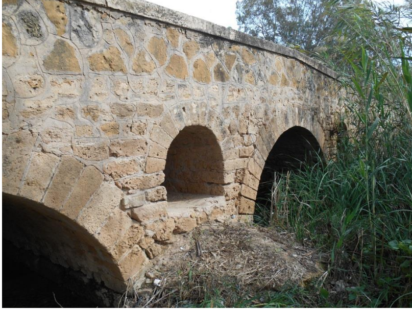
صورة 4. دعامة ضخمة محمية في الأسفل بمكسر مغمور بالطين وفي الأعلى بفتحة صغيرة. المصدر: صورة الكاتب.
