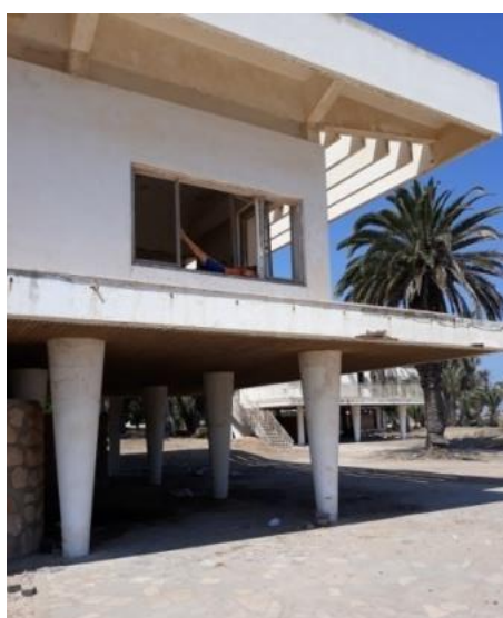
Fig. 4. Construction sur pilotis. Photographie personnelle. 2018.
