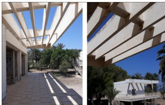
Fig. 6. Typologies de brise-soleil en béton armé courant tout autour des bungalows. Photographies personnelles. 2018.
