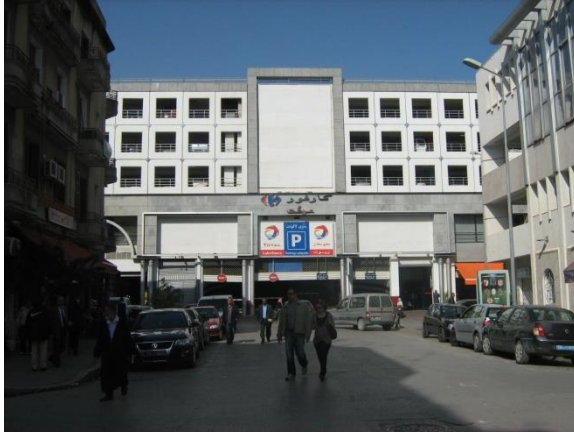
Fig. 8. Construction totale de la Place d'Utique et débouché des perspectives dans le quartier Lafayette. Source : Photo de l'auteur (2015).
