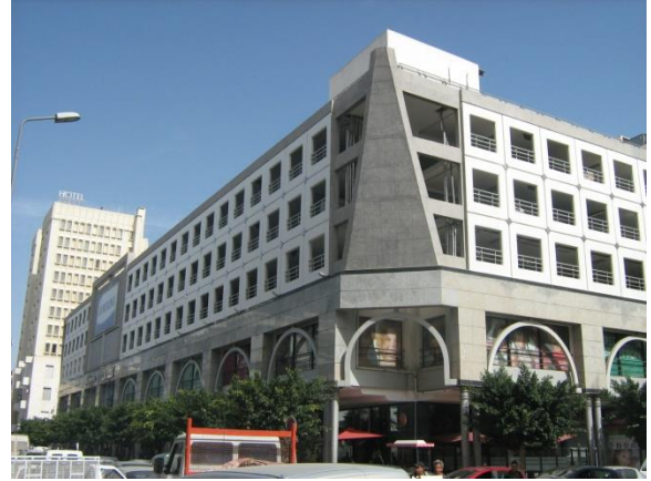
Fig. 9. Traitement d'angle du nouveau complexe immobilier. Source : Photo de l'auteur (2015).
