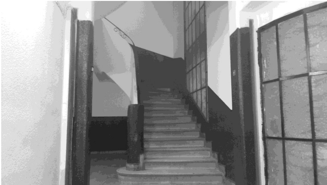
Fig. 13. Vue des escaliers depuis le hall de la rue Farhat Hached (Crédit photo : Lauren Etxepare).
