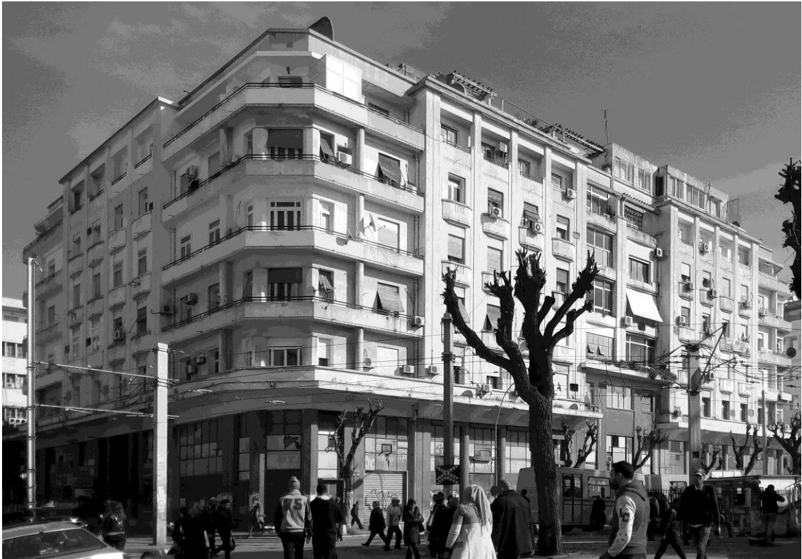
Fig. 12. Vue de l'immeuble Schwich et Baizeau . (Crédit photo : Lauren Etxepare).
