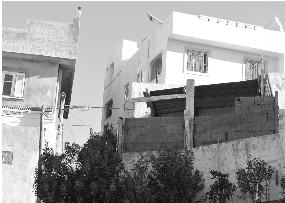
Fig. 23. Ensemble d'habitations en état de chantier avec des stades d'avancement variés.
