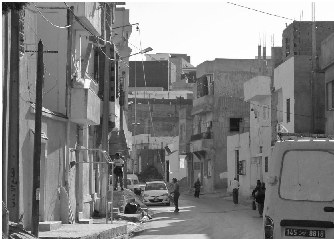
Fig. 25. Ensemble d'habitations en état de chantier. Nous constatons un souci d'extension verticale.
