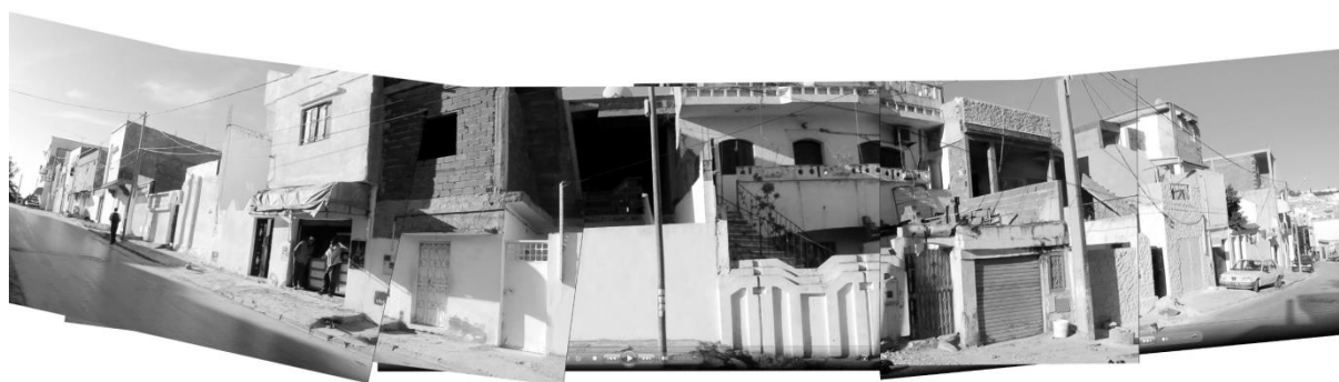
Fig. 26. Vue panoramique montrant un fragment de façade d'habitations inachevées, situées dans la partie haute du bidonville.
