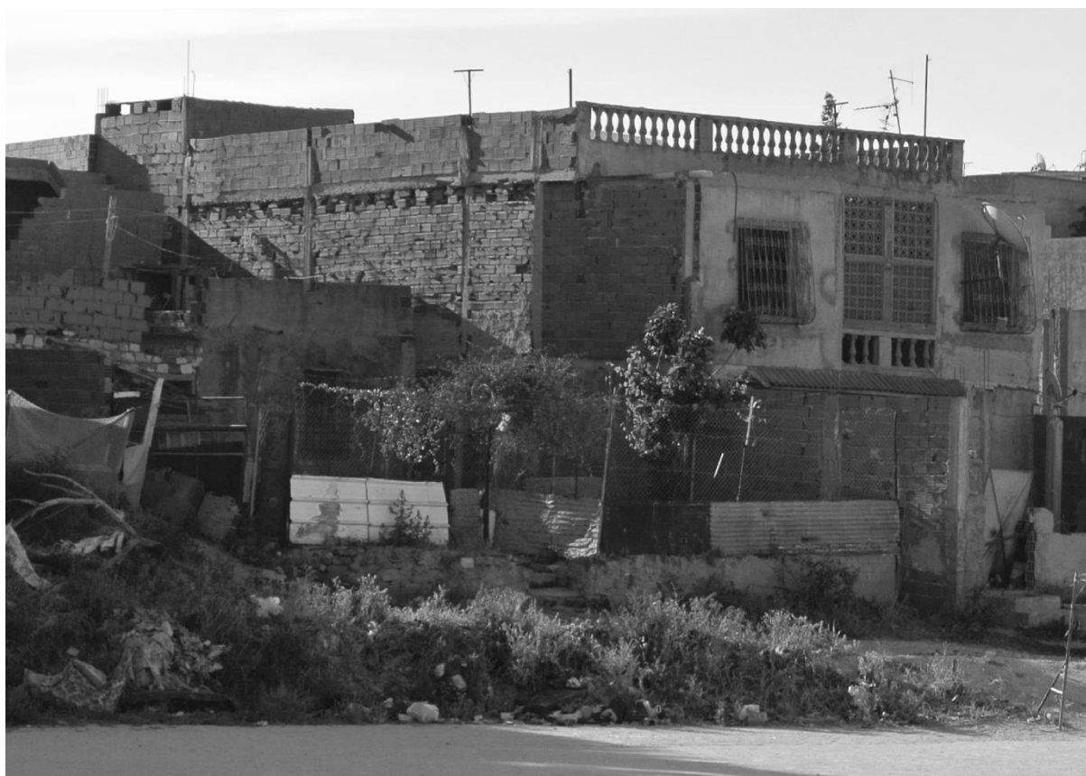
Fig. 20. Habitation en état de chantier. Les parois extérieures sont dépourvues d'enduit. La maçonnerie est en brique rouge.
