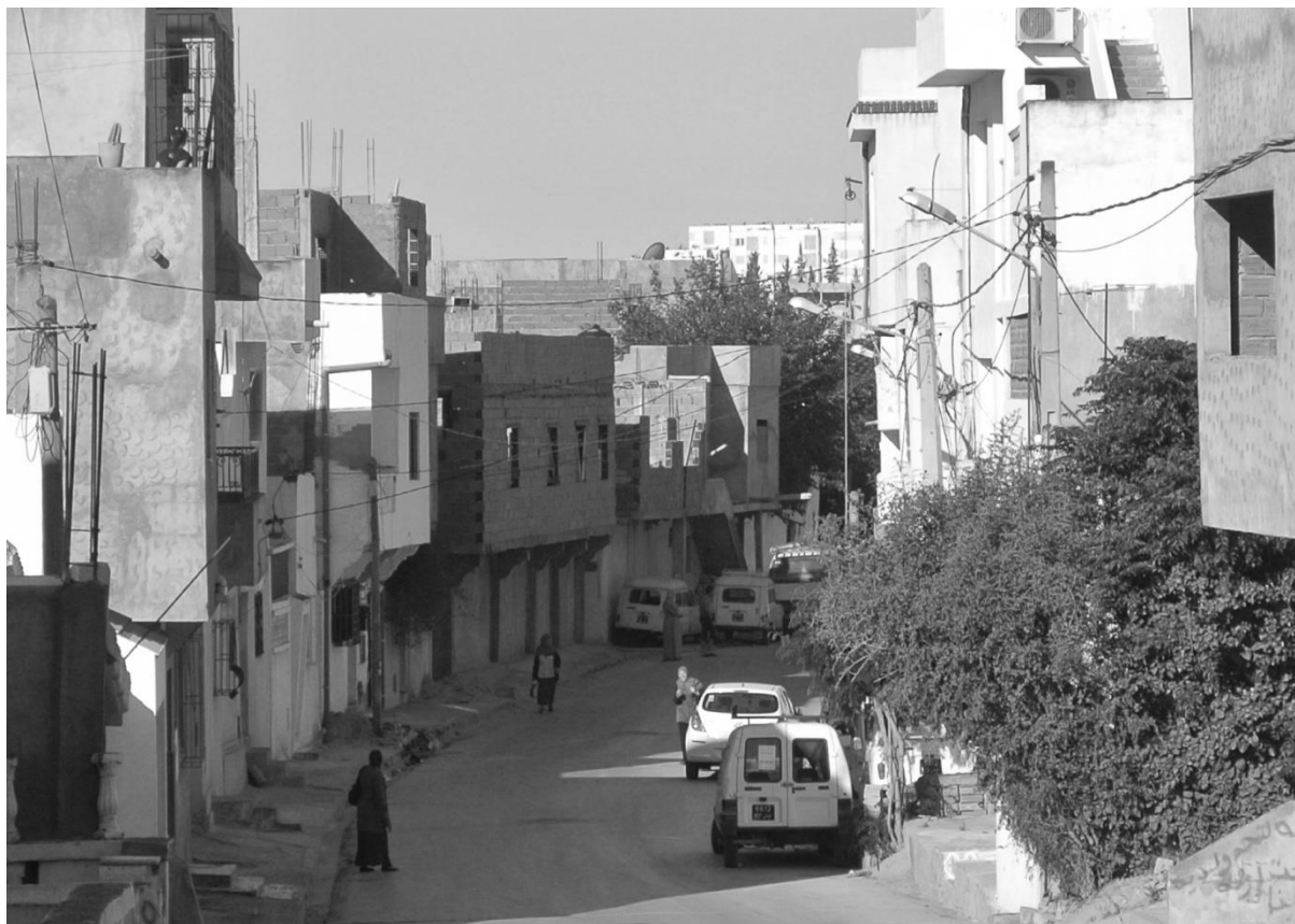
Fig. 31. Nous voyons, sur le toit des bâtiments, des armatures de poteaux. Cela suggère une volonté d'extension verticale.
