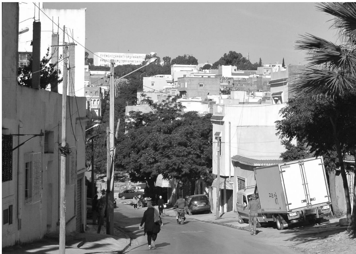
Fig. 33. Ensemble d'habitations en état de chantier avec des stades d'avancement variés.
