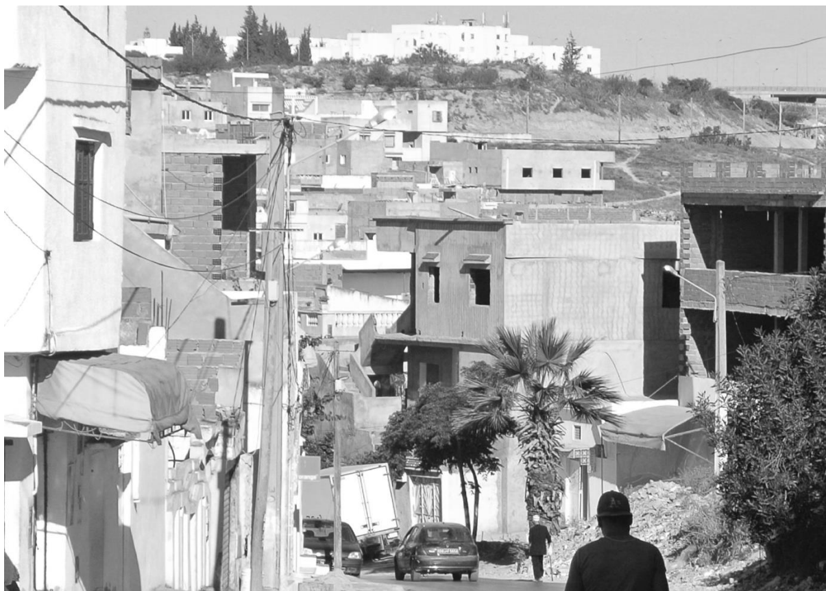
Fig. 32. Ensemble d'habitations en état de chantier avec des stades d'avancement variés.
