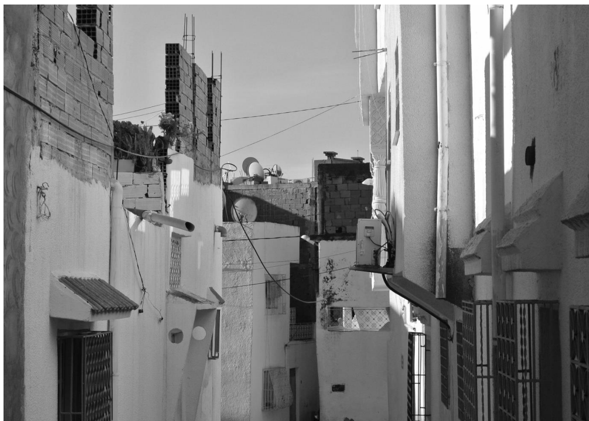
Fig. 22. Ruelle qui révèle un assemblage anarchique d'habitations. Le premier niveau est quasiment accompli. Le deuxième niveau est en cours de chantier.
