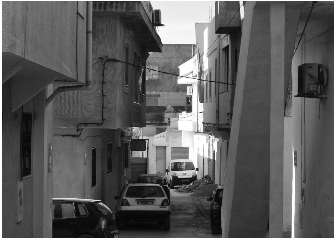
Fig. 15. Image montrant des habitations en état de chantier.
