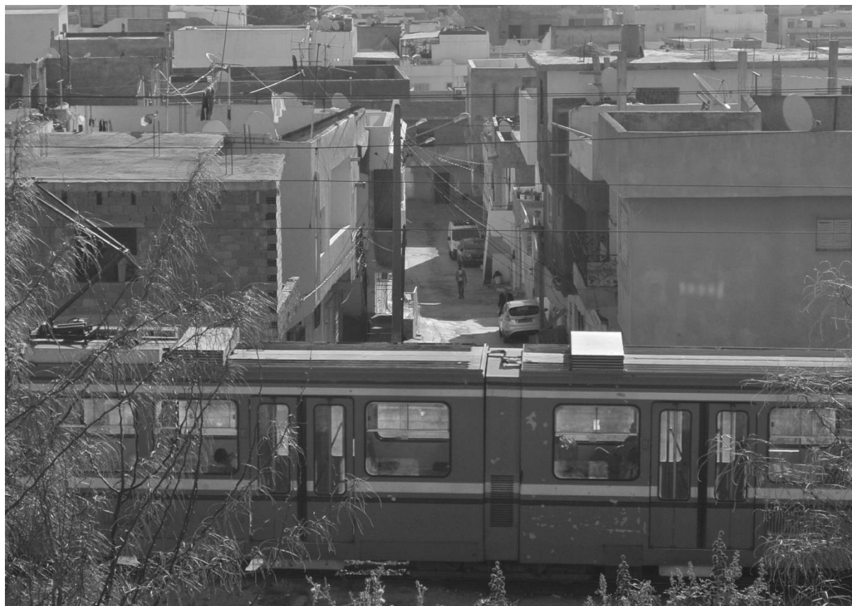
Fig. 10. Zoom pris depuis la station de métro « Romana ». La majorité des bâtiments qui figurent dans l'image comportent des étages. Nous remarquons que le deuxième niveau est, quasiment, en état de chantier, contrairement au premier niveau.
