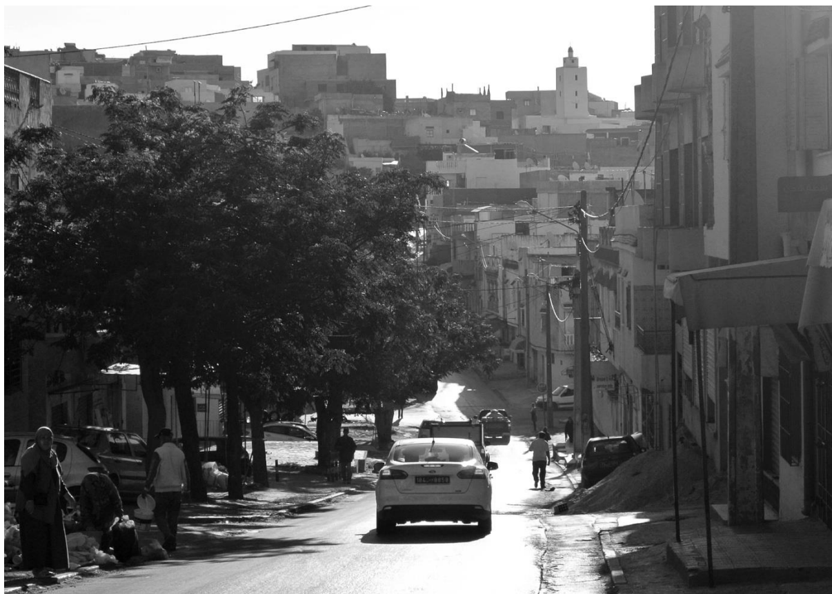
Fig. 12. Vue intérieure du bidonville montrant la densité du bâti. Nous remarquons que les rues sont goudronnées, équipées d'un éclairage public et d'un réseau d'électricité.
