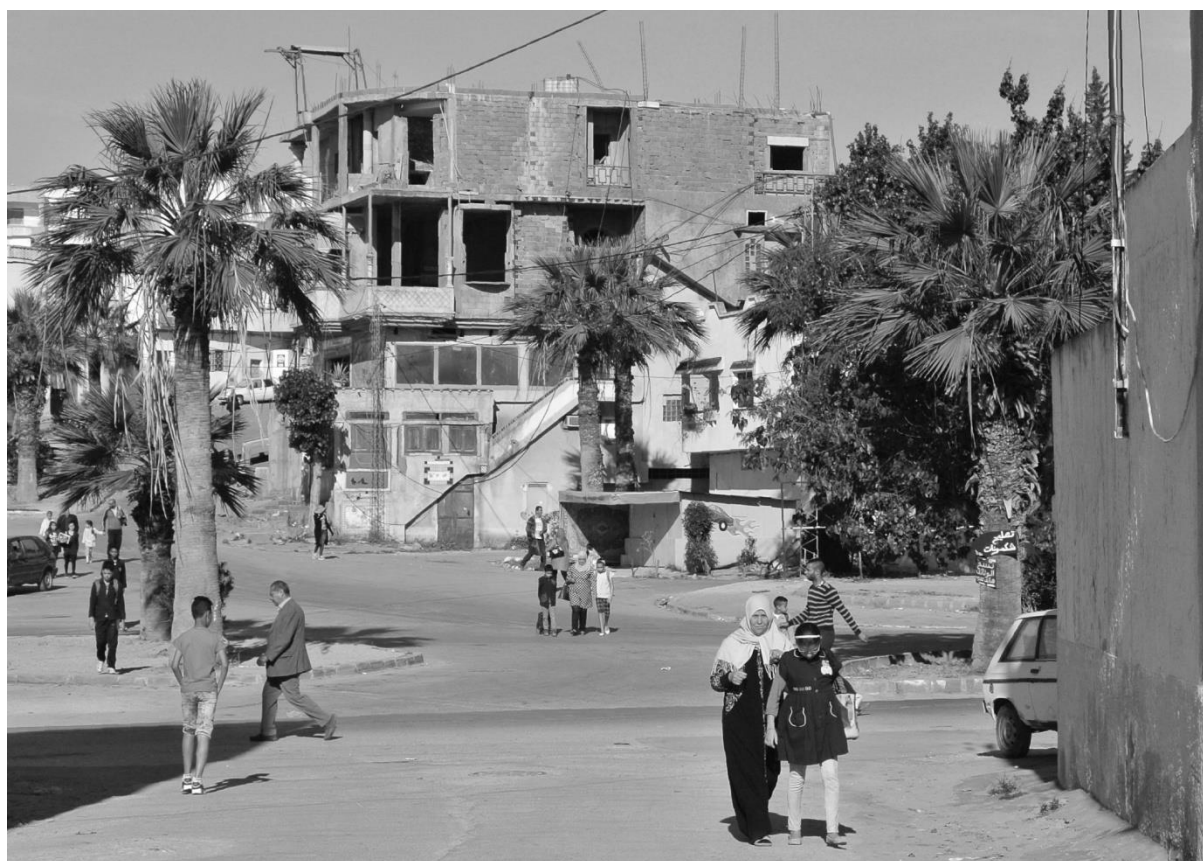
Fig. 36. Habitation inachevée à deux étages, située dans la partie basse du bidonville.
