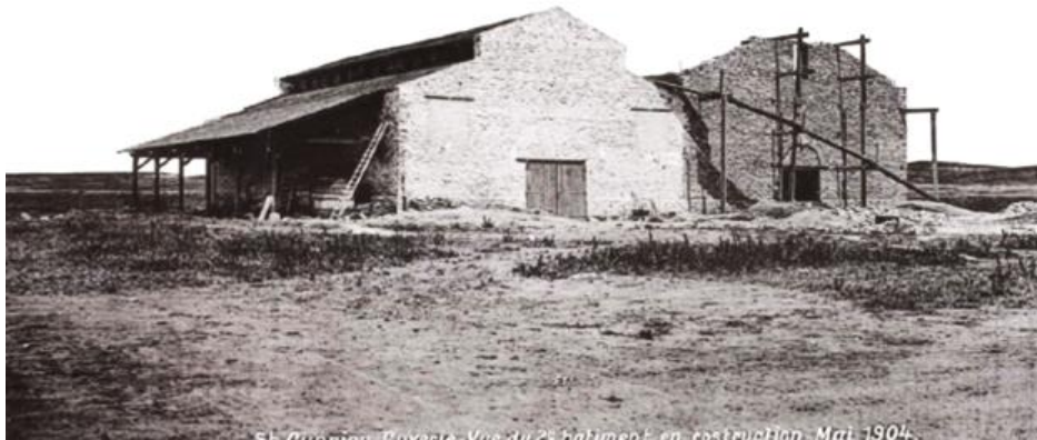
Fig. 2. Vue de deux fermes en construction à Saint-Cyprien 1904. Source : Ouvrage « La société des fermes françaises de Tunisie », 1906.
