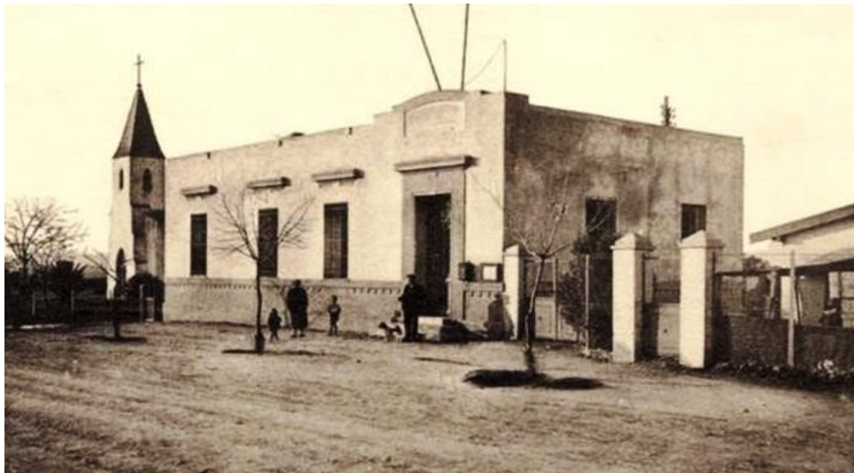
Fig. 13. Vue sur l'église et la poste
