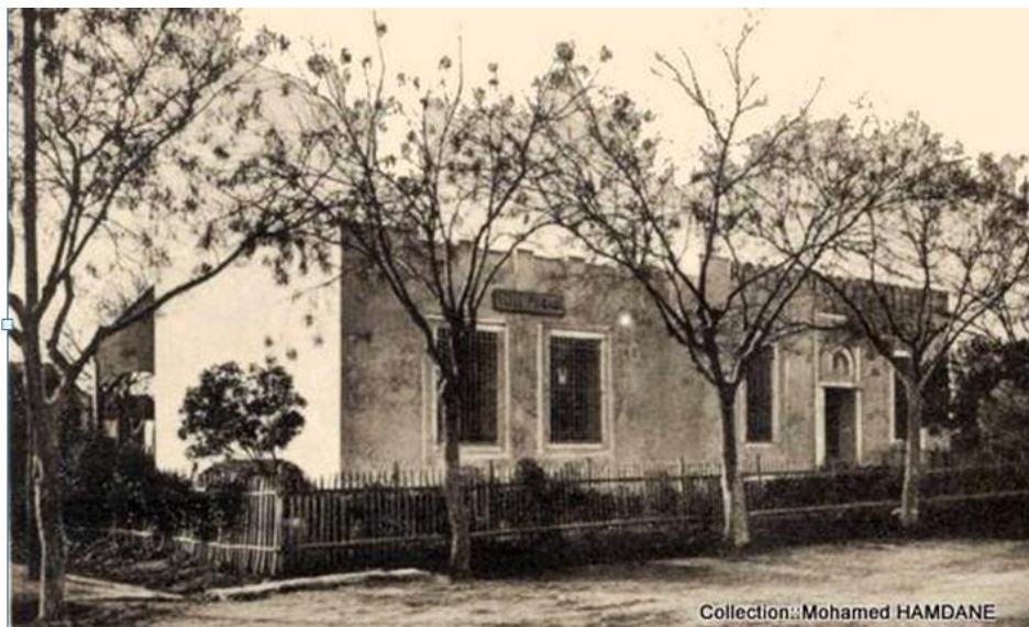
Fig. 8. L'école primaire de style arabisant construite en 1905.
