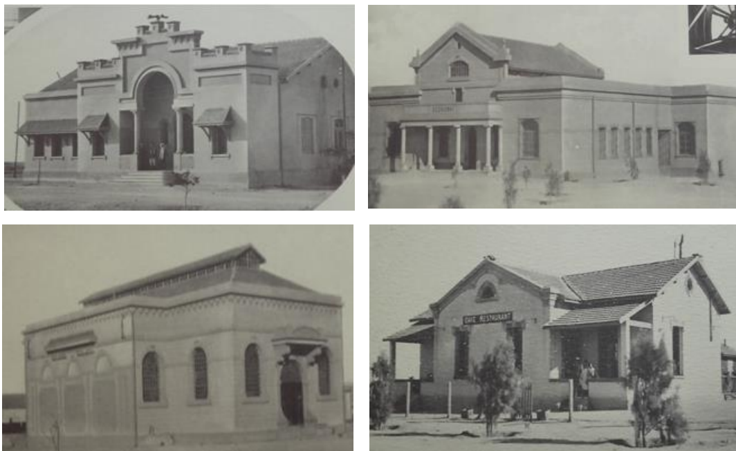
Fig. 12. Les différents équipements. Source : A. Perrin, Les Mines et installations de la Compagnie Tunisienne des Phosphates du Djebel M'dhilla, Travaux Photographiques d'Art, Tunis.
